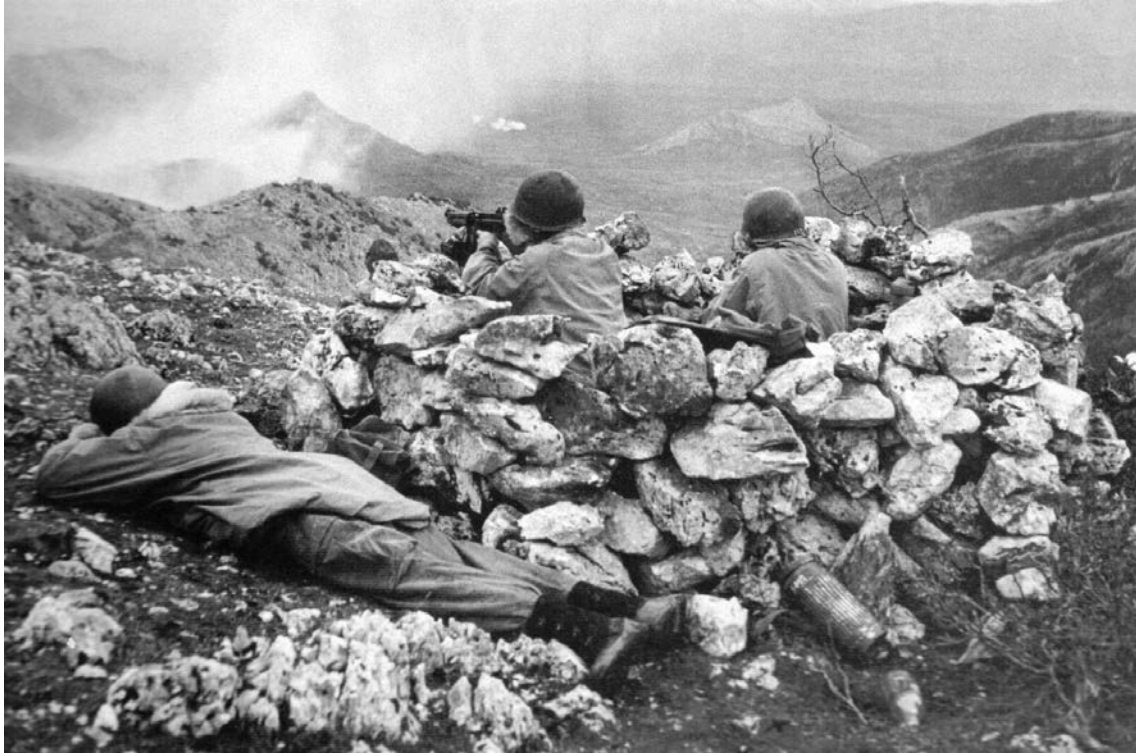
Figure n° 2 : Un abri de combat américain en pierre sèche, de type sangar, pour binôme, dans les montagnes du Latium (vallée du Liri) (cl. NARA). Des abris similaires sont connus dans les Alpes, n'étant pas excavés ils ne laissent quasiment aucune trace au sol excepté des amas de pierres.
