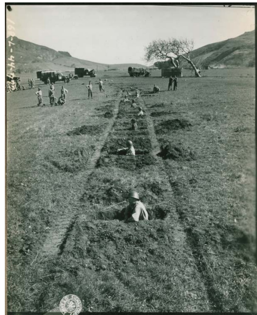
Figure n° 13 : Ces recrues du 155th US Engineers Training Camp de San Luis Obispo, Californie, sont entraînées en mars 1944 à creuser des trous d'homme au-dessus desquels passe un char (US Army Signal Corps, National World War Two Museum 2011-065-779)
