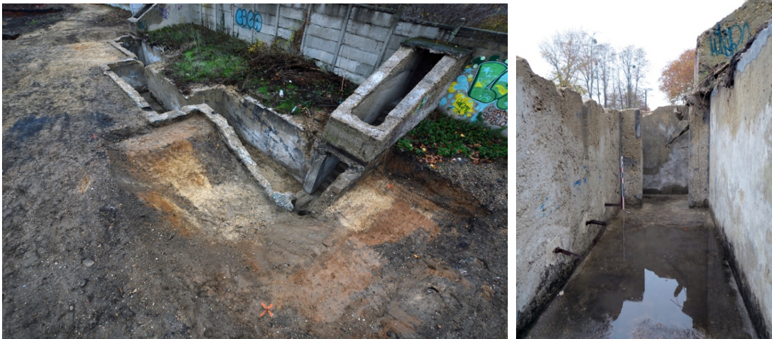
Figure n°3 : Vue d'ensemble de la tranchée-abri de la papeterie de la Seine et vue intérieur où subsistent encore les équerres de fixation des bancs, Nanterre (M. Belarbi, Inrap)
