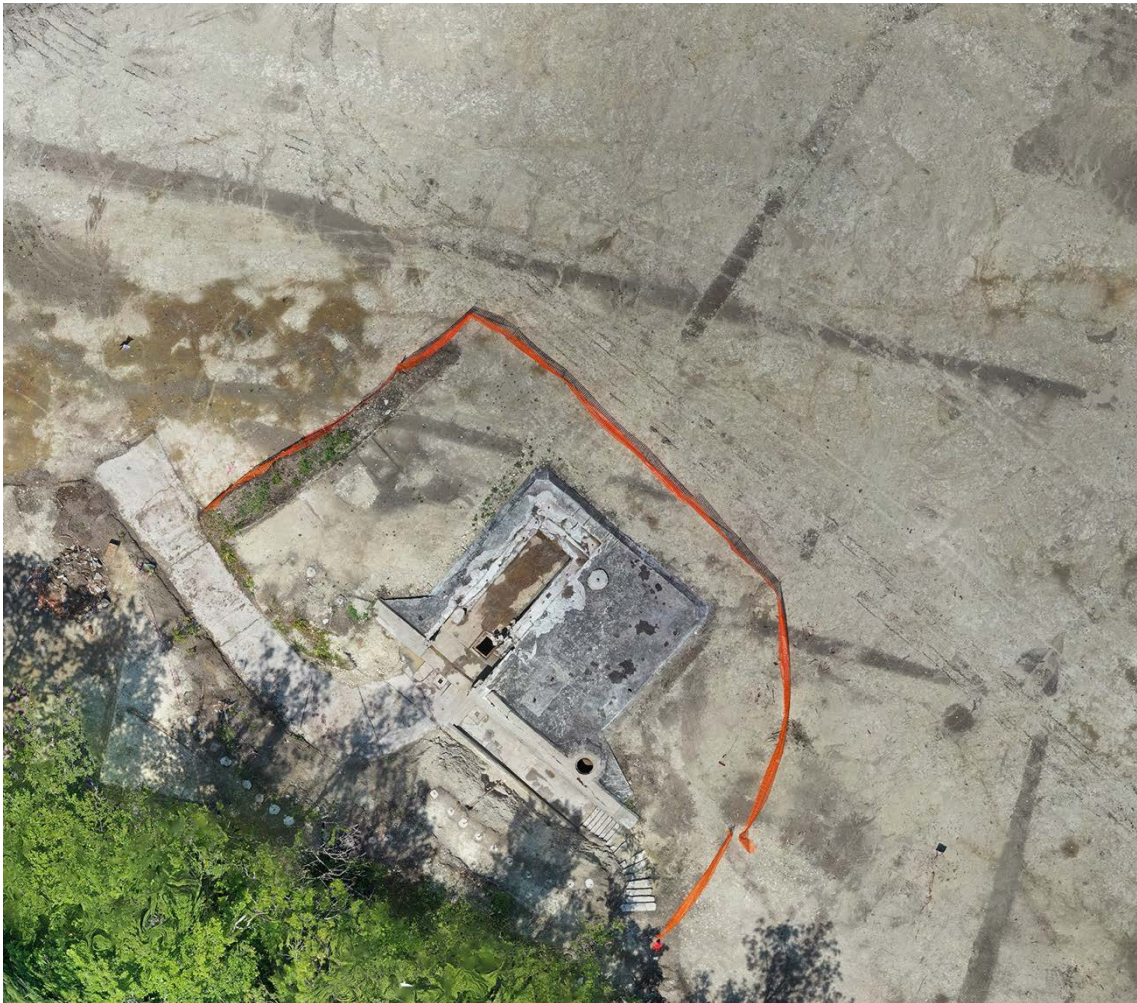
Figure n°5 : Plusieurs bunkers et structures datant de la Seconde Guerre mondiale étudiés dans le secteur de Royan, © Dép.17
