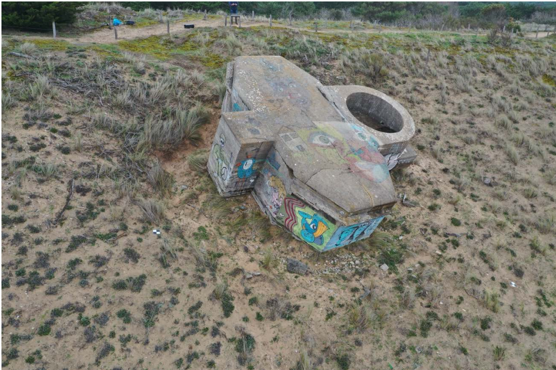
Figure n° 1 : Poste et cuve de télémétrie de la batterie française à Sainte-Marie-de-Ré située sur l'île de Ré (17), © Dép.17
