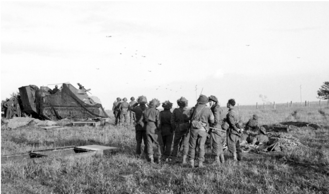
Figure n° 14 : Artilleurs de la 3rd Inf. Div. britannique regardant l'arrivée des planeurs de la 6th Airborne Division, non loin de Blainville-sur-Orne, au nord de Caen, le soir du 6 juin 1944. On distingue au sol des trappes préfabriquées destinées à couvrir leurs abris de commandement souterrains, en attente d'être creusés, ainsi que des trous d'homme de première instance pour un groupe de soldats à droite (coll. IWM, n° B5046, détail)
